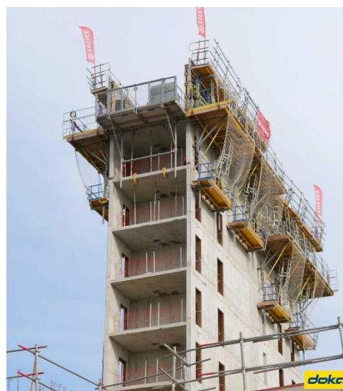
Construction du noyau en béton de la Tour Hypérion grâce à notre outil grimpant composé du coffrage FRAMAX XLIFE, de la console MF
