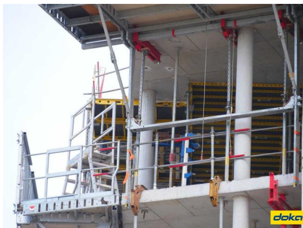
Le coffrage de plancher du noyau de la tour a été réalisé grâce au Dokadek 20.
