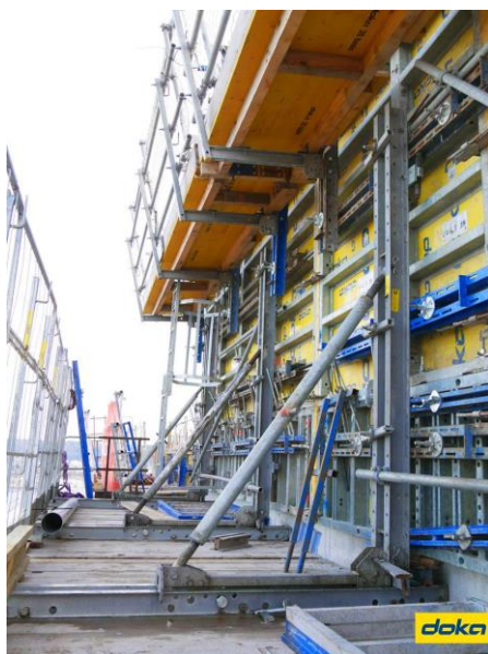
L'outil de coffrage grimpant est composé du coffrage FRAMAX XLIFE, de la console MF 240 et des nacelles.
